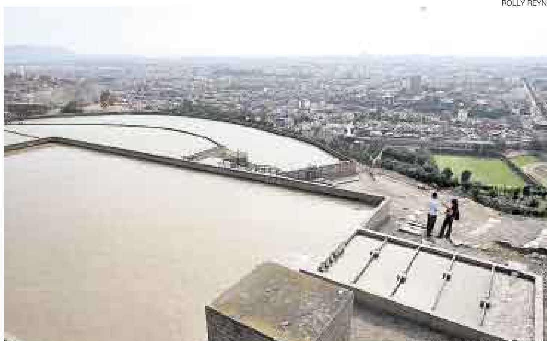
LAGUNAS. El colegio de La Inmaculada tiene un sistema de lagunas a desnivel para tratar sus aguas.
